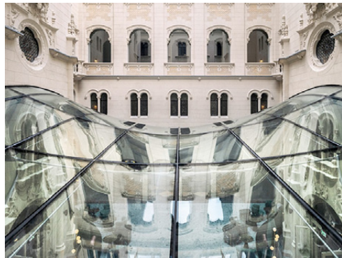
Überdachung eines Innenhofes Banati/Hartvig Architect Studios, Ungarn
